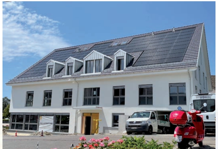
Photovoltaik Indachanlage, Kronenstrasse 1, Stäfa
